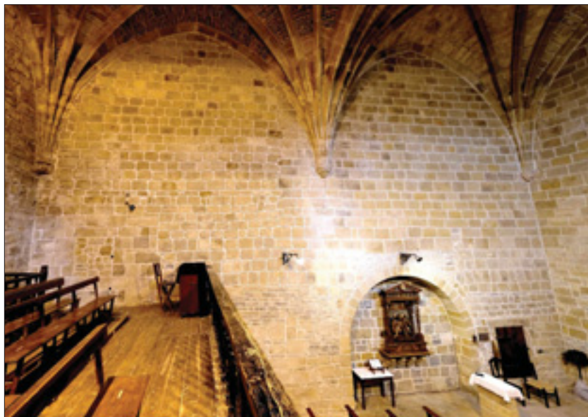
Fig. 32. San Martín de Askizu: Vista de conjunto del paramento interior del muro norte, con el despiece de los aparejos.
