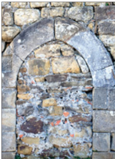
Fig. 12. San Martín de Askizu, puerta plana y tapiada, entre el aparcamiento occidental de vehículos y el pórtico meridional.
