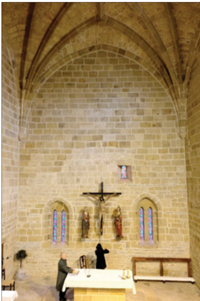
Fig. 30. San Martín de Askizu: Aparejos interiores del testero oriental, con la huella del piñón medieval y las hiladas de lajas interpuestas para ir encajando los sillares del recerco de las ventanas.
