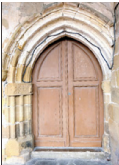
Fig. 11. San Martín de Askizu, la portada meridional, luciendo un típico diseño de tendido eléctrico, tradicional en el Patrimonio Español curiosa bóveda leñosa enlistonada.
