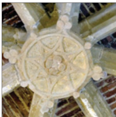
Fig. 20. San Martín de Askizu, clave central de la bóveda sobre el coro, con el mismo diseño octogonal que la clave del arco fajón, pero más grande y con festones trebolados.
