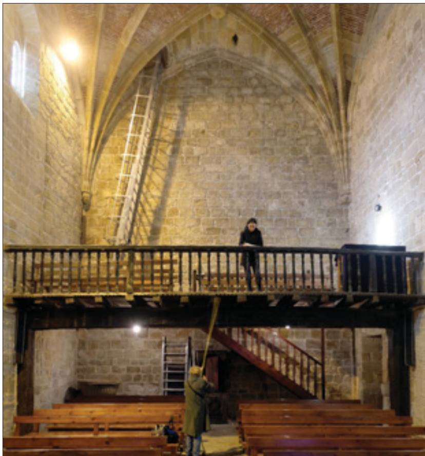
Fig. 34. San Martín de Askizu: Paramento interior del muro occidental, es el más moderno del edificio, y sin duda por ello, también el más homogéneo de todo el edificio, con el corito elevado y las inestéticas (pero necesarias) escaleras metálicas (quien se ha cimbrado en una escalera oscilante, agradece la seguridad).
