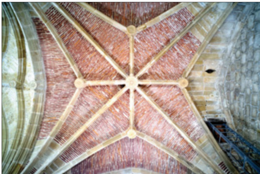
Fig. 16. San Martín de Askizu: Bóveda sobre el coro, igualmente gótica de terceletes, con nervios de piedra arenisca, pero con plementos de ladrillo macizo y losas de arenisca en el acceso a la cubierta. El detalle permite ver el huequecillo, previsto para pasar una cuerda para tañer las campanas, cuyo desgaste indica su empleo. Obsérvese, también, cómo las claves son más grandes que en la otra bóveda, algo más antigua.
