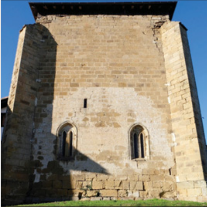
Fig. 9. San Martín de Askizu, fachada oriental, con su par de ventanas medievales geminadas y las huellas preservada por un irreductible lucido de cal que insinúa el piñón de un edificio más bajo, pero no se extiende a los inmediatos contrafuertes.
