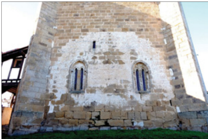
Fig. 17. San Martín de Askizu, fachada oriental, con su par de ventanas medievales geminadas y las huellas preservada por un irreductible lucido de cal que declara el piñón de un edificio más bajo, pero no se extiende a los inmediatos contrafuertes
