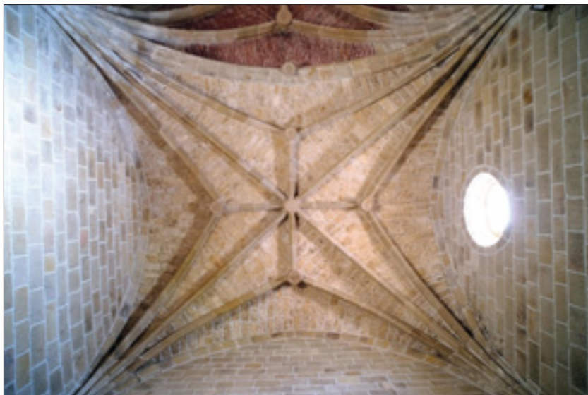
Fig. 15. San Martín de Askizu, bóveda sobre el presbiterio, gótica de terceletes, con sus nervios de arenisca y sus plementos de toba.
