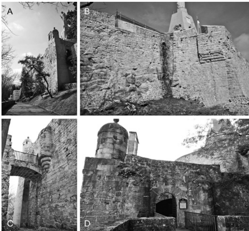
Fig. 14: A y B) El revellín y las torres con adarve amatacanado sur y este (1548-50). La estructura, apoyada sobre la roca recortada, amenazó ruina, y las torres citadas tuvieron que ser reforzadas con un contrafuerte. El pretil y troneras son posteriores. C y D) Acceso este al revellín (1548-50), aún conserva la parte inferior de sendas escaraguaitas que lo flanqueaban, así como la huella de las aberturas para izar el puente levadizo.
