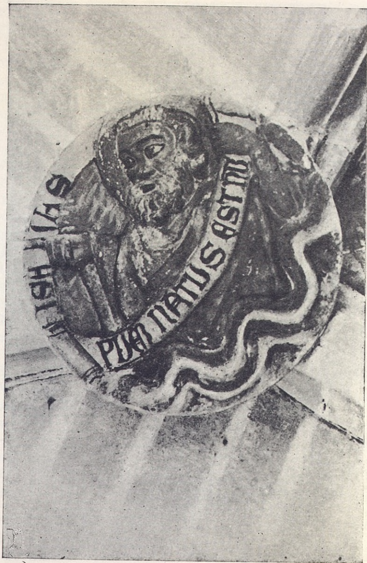
Clave de bóveda.
