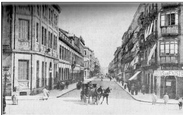
FIGURA 12: Calle Garibai desde Peñaforida. En la esquina con la calle Andia, a la izquierda, se alza el inmueble proyectado por el arquitecto Goicoa. Fuente: PLACER/ URKIA [1993]
