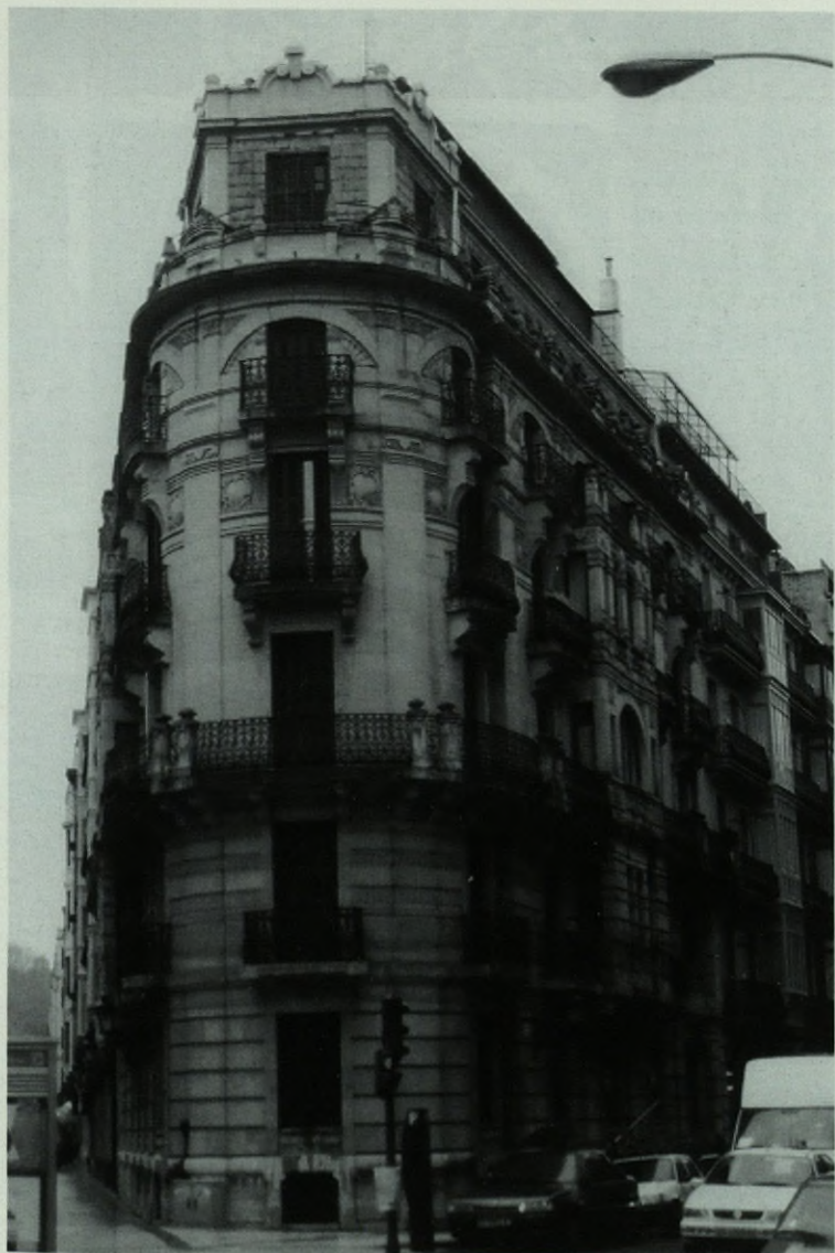
Edificio de la calle Prim 22. Juan-Rafael Alday, 1905.
