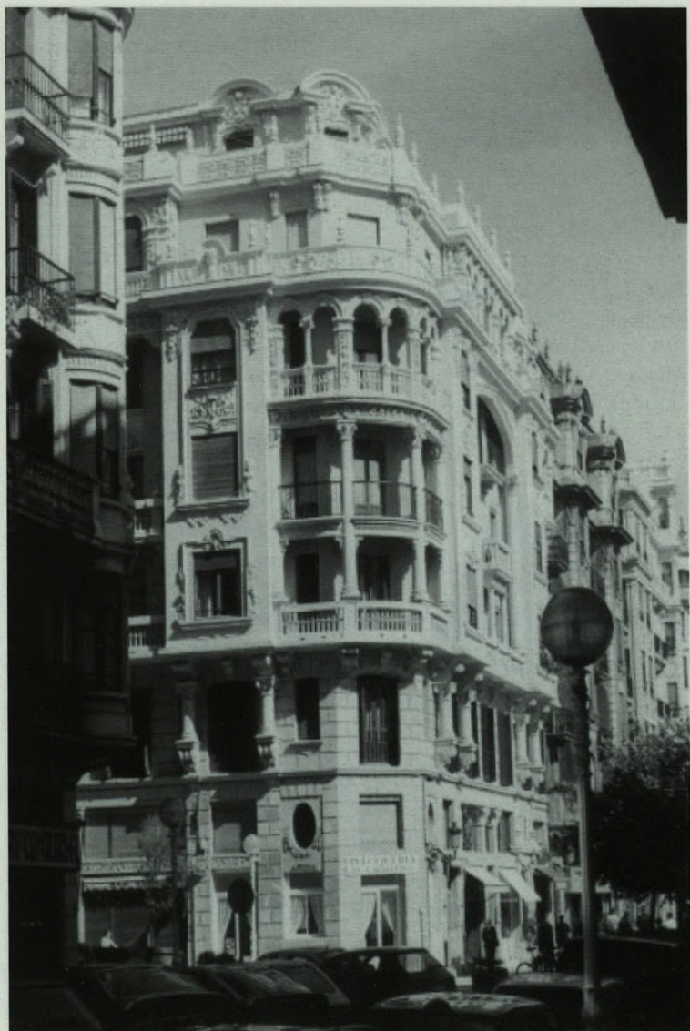
Edificio de la calle Usandizaga 21. Ramón Cortázar, 1926.
