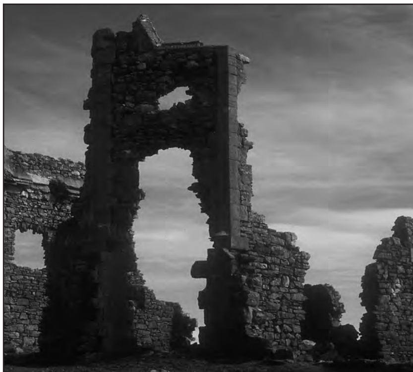
II. 9. Ruinas en rápido deterioro del torreón central del fuerte de Pagogaña
