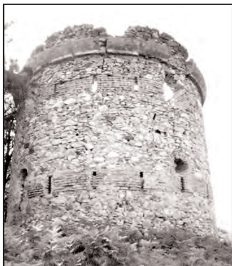
II. 5. Vista general del torreón Pika
