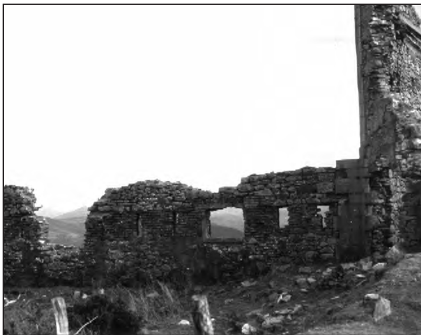
Il. 11. Vista parcial del Fuerte de Pagogaña. Se aprecia el único lienzo de nave que conserva ventanas y aspilleras
