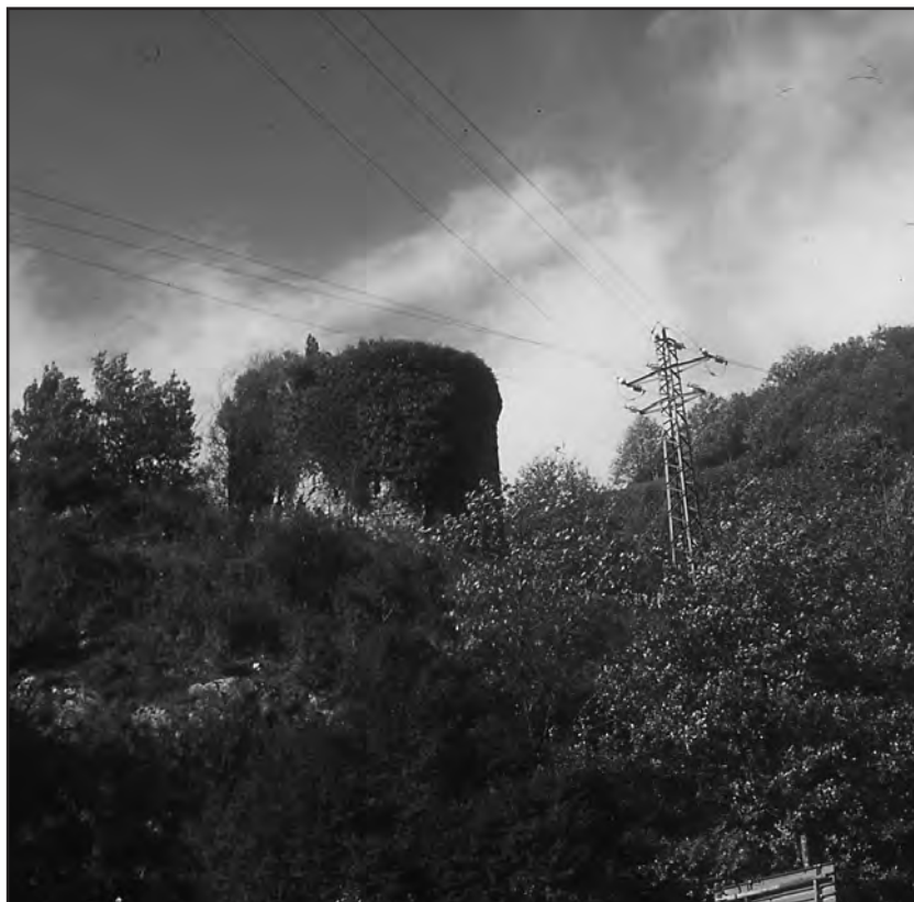
II. 3. Torreón de Endarlaza, cubierto por la vegetación.
