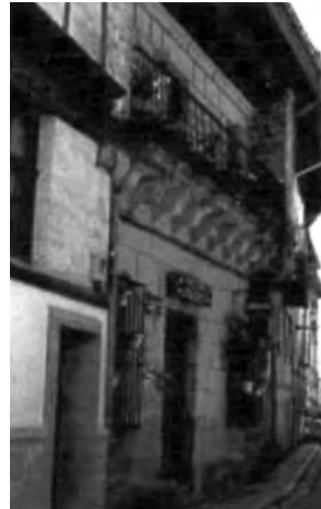
Conjunto de casas en la calle Mendiburu.
