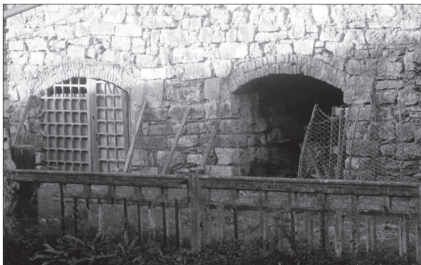
Dos de las tres bocas de descarga del horno cementero de Fagollaga.
