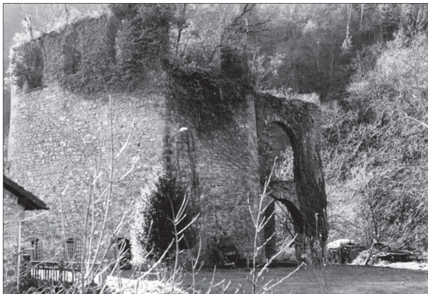
Vista de las bocas de descarga de las tres cubas de cocido del horno cementero de Fagollaga.
