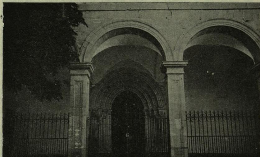
Fig. 3. El pórtico en su estado actual.
