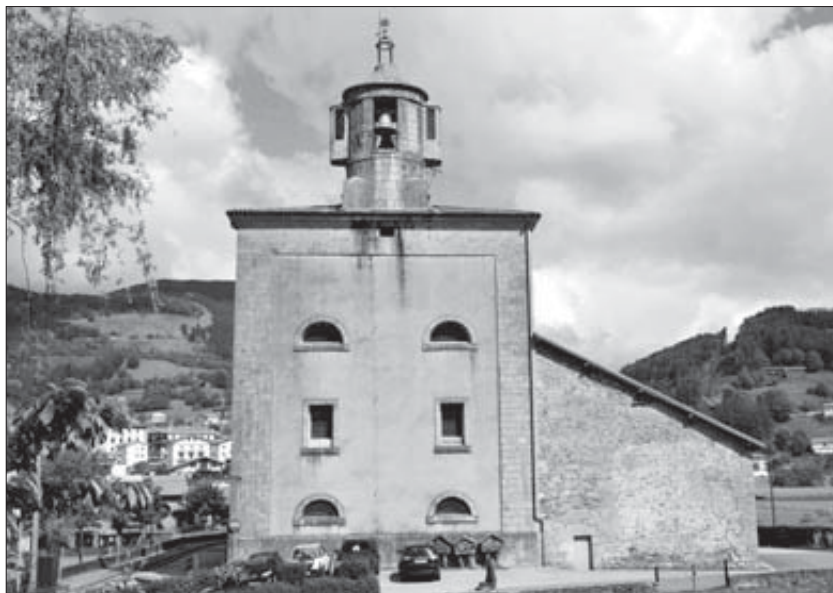
Ilustración 8: Fachada occidental del templo parroquial de Berástegui, con la académica alternancia de vanos y su original torre centrada. ¿Por cierto, quién ha tenido la idea –no menos original– de añadir los dos volúmenes a cada lado como si fueran orejitas?
