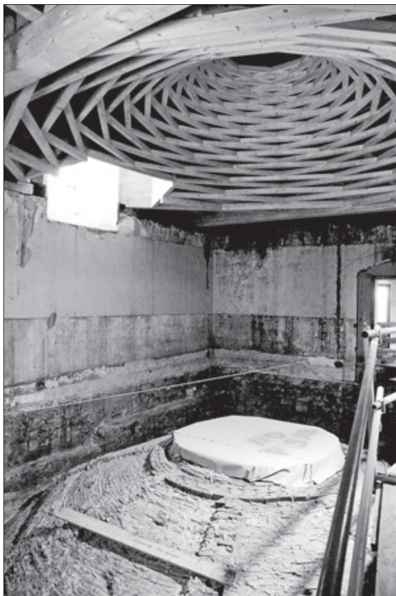
Fig. 10. Segunda planta de Santa María: La cúpula sobre la Capilla del Trascoro, durante su restauración, con la exhibición de la “martingala” del Transparente. En primer término, el extradós nervado de la cúpula de ladrillo, con el óculo, ya abierto, en su centro. En aquellos momentos, éste estaba cerrado con una tela sobre la que un rotulo con letras rojas advertía perentoriamente “no pisar” (de ahí el interés de saber leer). El forjado previsto respetaría el vano y los materiales precedentes, soslayando siempre el uso de refuerzos metálicos y sus riesgos de oxidación en zonas inaccesibles al mantenimiento. En cambio, se aceptaría la licencia anacrónica de utilizar en su soporte madera de elondo, bastante más resistente que la de roble. Por encima de todo ello pueden verse los arranques de una falsa bóveda a medio montar, hecha a base de listones de madera; un dispositivo vistoso y económico, expresamente diseñado para contribuir al decoro de aquel ámbito de carácter tan ambiguo. Sobre el muro de la izquierda puede verse el ventanuco del tragaluz, plenamente funcional. El rayo que penetra a su través alcanza la esquina inferior derecha de la foto. La idea era que la luz procedente de aquel tragaluz pareciera provenir de la reconstruida cúpula, para lo que se empanelaron y enjalbegaron sus triángulos.
