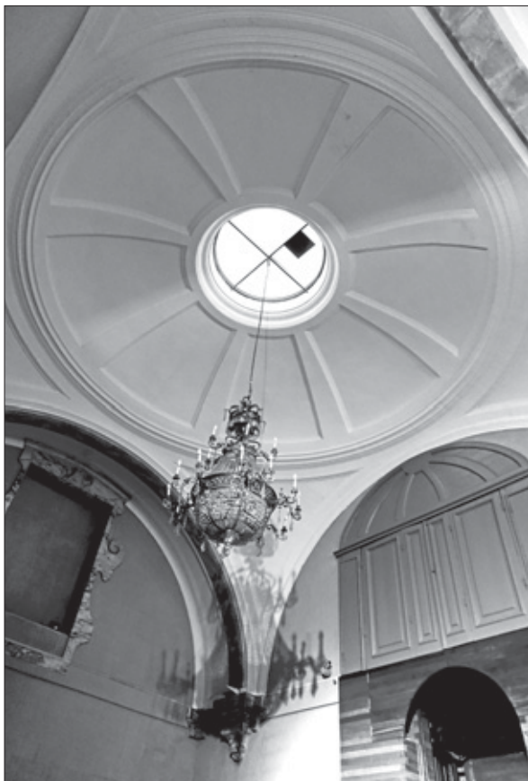
Fig. 11. Imagen actual de la Capilla del Trascoro, con la bóveda esférica rebajada y, en su centro, el óculo del Transparente y su vidrio de seguridad. Colgando del centro de éste, la araña de siempre, ahora restaurada. A la derecha de la estampa, pintadas de gris, las puertas-telón de la boca posterior del Camarín. Debajo de ellas, la decoración enlistonada dispuesta para el altar. A la izquierda, el nicho del falso ventanal allí puesto para mantener la simetría de la composición, en su día cubierto por una vidriera de Maumegean, representando la entrega de un manto a la Virgen del Coro efectuada por el general Francisco Franco en presencia de Juan María de Araluce, hoy ya retirada pero almacenada (aquí, como en las buenas cocinas, no se tira nada). Quizá intrigue al observador la presencia del cuadradito oscuro que ocupa parte del vidrio de seguridad en el óculo. Es la base de una vitrina de la exposición de Oteiza organizada durante el verano de 2022 por nuestro querido amigo Edorta Cortadi. La constatación de aquella —por supuesto que inadvertida— fechoría nos convenció de la necesidad de disponer allí arriba de una oportuna explicación a la que corresponde el presente artículo informativo.
