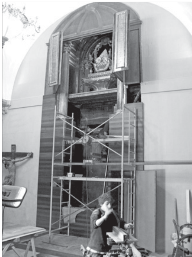
Fig. 6. La Capilla del Trascoro durante los trabajos de rehabilitación, ya desmontado el forjado de hormigón que subdividía el ámbito y con la perforación del Camarín abierta, pero sin colocar aún el montacargas necesario para mover la imagen de la Virgen del Coro para limpiarla, vestirla, enjoyarla y florearla.
