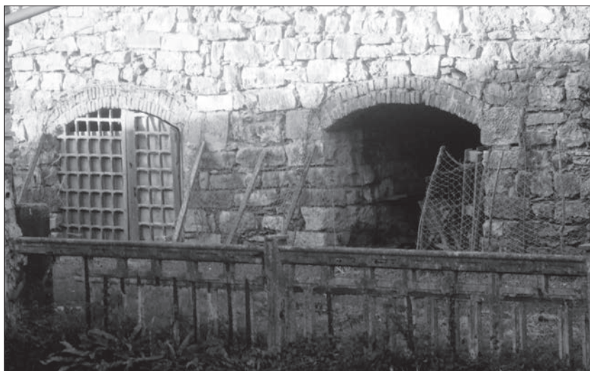
Dos de las tres bocas de descarga del horno cementero de Fagollaga.
