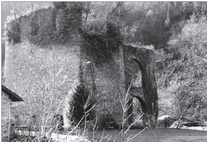
Vista de las bocas de descarga de las tres cubas de cocido del horno cementero de Fagollaga.
