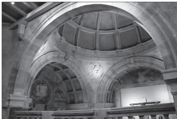
Fig. 06. Cúpula casetonada como cubrición a la planta cuadrada de la capilla.
