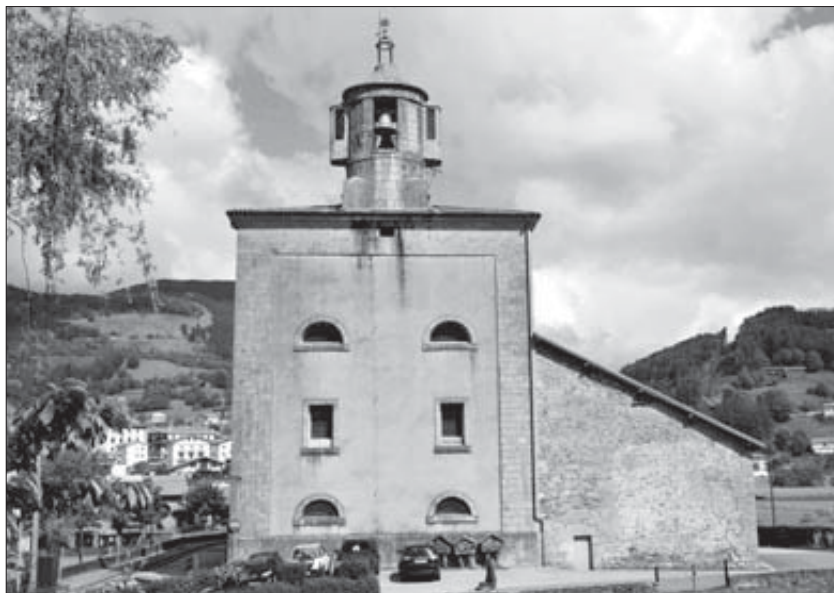
Ilustración 8: Fachada occidental del templo parroquial de Berástegui, con la académica alternancia de vanos y su original torre centrada. ¿Por cierto, quién ha tenido la idea –no menos original– de añadir los dos volúmenes a cada lado como si fueran orejitas?
