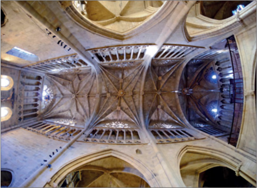
Fig. 7: Interior del templo parroquial de Getaria, hacia las bóvedas, que parecen surgir del elevado triforio que rodea la nave por sus cuatro lados. A partir del nivel de arranque de esa planta, es perceptible un cambio de intenciones y hasta de color. Sobre el nivel de gótico clásico con sus bóvedas cuatripartitas se encarama una construcción aligerada con piedra de toba y calada con bóvedas estrelladas y de terceletes. Eso puede suponer un siglo de evolución en el estilo.
