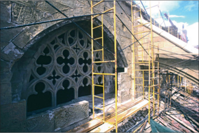
Fig. 20: San Salvador de Getaria, tramo del claristorio con su tabicado demolido. De pronto, la imagen de lo obvio se impone sobre las convenciones y los hábitos adquiridos. Véase, de paso, cómo el arbotante se va para arriba .
