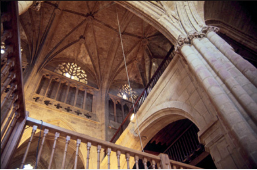
Fig. 24: San Salvador de Getaria, vista de las bóvedas desde el umbral de la puerta norte, correspondiente al del suelo inicialmente previsto. Junto al borde superior de la imagen, cruce de nervios característico de las bóvedas de la colateral norte; la sur no los tiene. Es muy posible que esta vista sólo haya sido posible desde finales del siglo XX, cuando se recuperó el empleo y nivel del acceso norte del templo.
