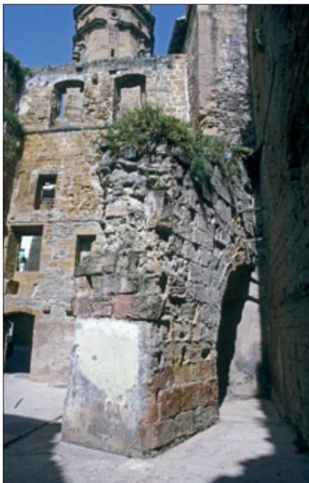
Fig. 14: Ruina de la Casa de los Zarauz, de la que sólo quedan los muros perimetrales. En primer término, el “caño”, un tosco y masivo arbotante que resultó de la Sentencia de 1495.
