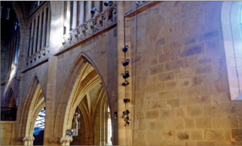
Fig. 10: San Salvador de Getaria: En primer término, “pentimento” de arco en el muro norte del presbiterio. ¿Qué se quiso hacer allí? Y sobre éste, el poderoso triforio. Obsérvese que la imposta que marca su arranque en la nave no se alinea con la correspondiente al presbiterio, lo que coincide en señalar la absorción de cambios sobrevenidos.
