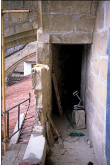
Fig. 16: San Salvador de Getaria: El ándito perimetral del claristorio. Obsérvese el escaso espesor de los muros, nunca superior a los 20 cm, y cómo los arbotantes (¡menos mal!) vienen a coincidir con el macizado de los pilares. Detalle aun más inquietante: El ándito interrumpe ese macizado de los pilares, de modo que, como puede verse en la fotografía, los arcos fajones deben conformarse con apoyarse en esas delgadas fábricas y en lo que queda del pilar interior, cuya entidad y dimensiones pueden verificarse en la planta de la figura 13. Milagroso.
