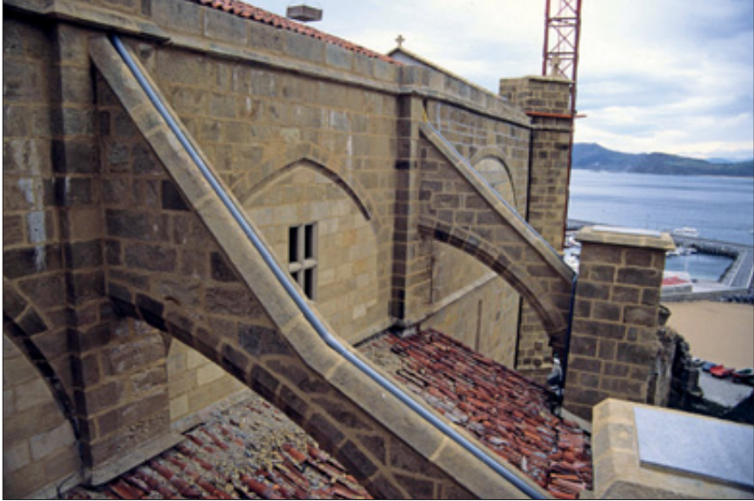
Fig. 17: San Salvador de Getaria, fachada sur: El arbotante que se entrega a la torre, con el extradós quebrado . Los arbotantes suelen trabajar como brazos apoyados desde los codos facilitados por los contrafuertes externos, y contrarrestan el empuje de las bóvedas apoyando los dedos estirados de la mano. En Getaria, esas manos se apoyan, con la palma abierta .
