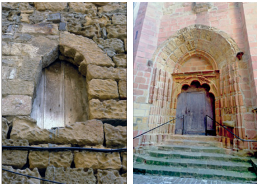
Fig. 5: Ventanita enmarcada en un polilóbulo —cuya mitad izquierda está torpemente rehecha— en la fachada de la casa de los Zarauz y portada occidental polilobulada del templo.
