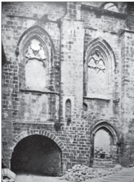
Fig. 22: San Salvador de Getaria tal y como estaba a comienzos del S. XX, quemado, hecho cisco, rodeado de escombros y con su puerta norte y todos los ventanales tapiados con mampostería ordinaria. El arquillo claro entre los ventanales es un paso para un ándito de flanco para la Catrapona que debió perderse hacia ya mucho.
