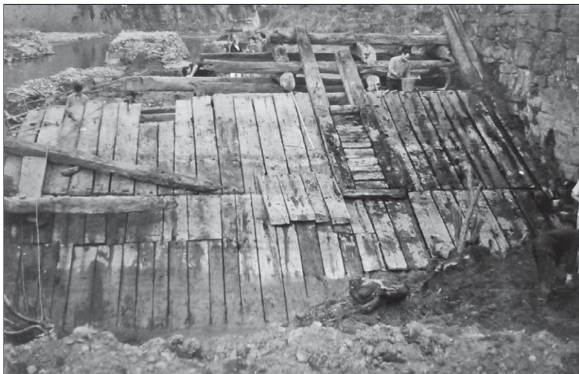
Foto 4: Presa de Igartza durante su excavación
