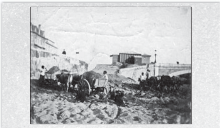
10 Areneros en el Urumea a la altura del Puente de Santa Catalina, en Donostia-San Sebastián, Gipuzkoa. 1893. Albumina 17 x 12 cm. Autor: Rogelio Gordón.
