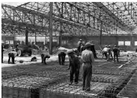
Construcción fábrica Michelin, 1965. ATHA-SCH-PC-15711
