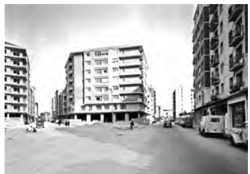
Edificios en construcción 1960-1970, C/Angulema-División Azul. ATHA.SCH.PC.24022
