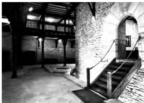
Rehabilitación Casa del Cordón, 1964. ATHA-SCH-PC-28446
